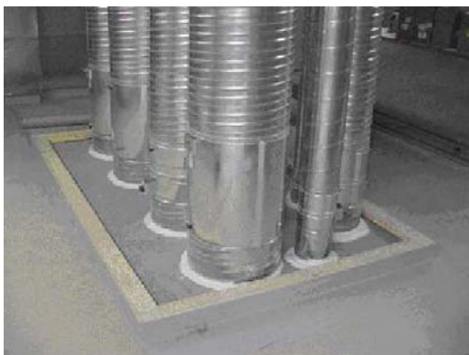
Kuva 5. Pystyosien, kuten katon tai lattian läpivientien tiivistäminen estää tehokkaasti palon leviämisen palo-osastosta toiseen yhdessä muiden paloturvallisuustoimien kanssa. (Palopellit kuvan ilmanvaihtokanavissa on asennettu alapuolelle).
