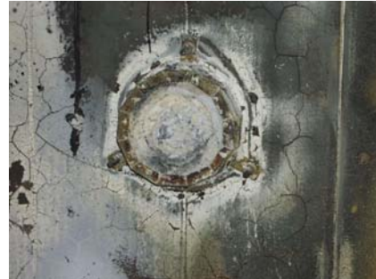
Kuva 4. Palonsuojamansetti estää tehokkaasti tulipalon leviämisen tiivistämällä sulaneeseen muoviputken syntyneen aukon.
