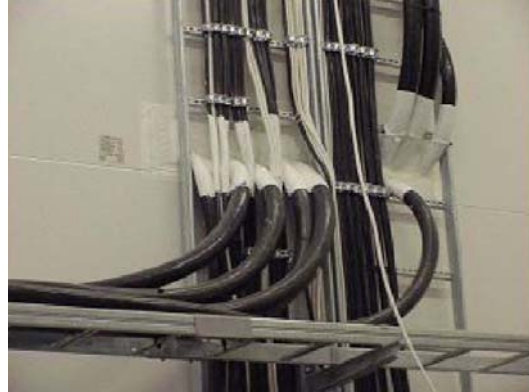
Kuva 3. Palokattojen asennus vaatii ammattitaitoa.
