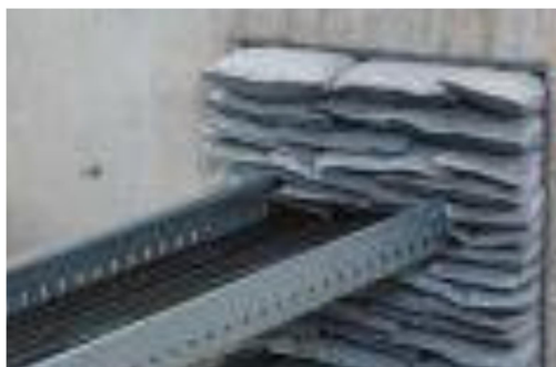
Kuva 13. Palokatkotyynyjä ja -pusseja voidaan käyttää tilapäisinä tai pysyvinä palokatkoina.
