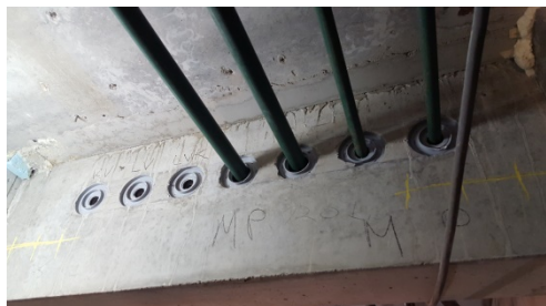
Kuva 15. Esivalmistetut läpivientikappaleet voidaan asentaa tehtaalla valmiiksi elementteihin (vasemmalla) tai työmaalla esimerkiksi ennen valua (oikealla).
