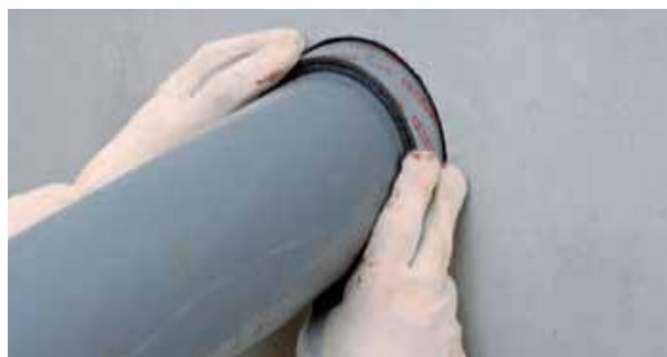
Kuva 10. Wrap –nauhan asennus muovisen viemäriputken ympärille. Toimii kuten kuvassa 11 toiminut palomansetti.
