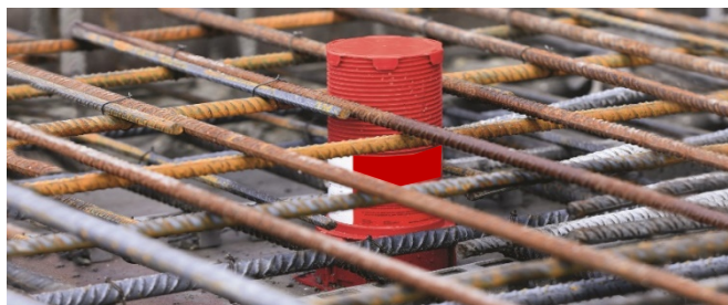
Kuva 15. Esivalmistetut läpivientikappaleet voidaan asentaa tehtaalla valmiiksi elementteihin (vasemmalla) tai työmaalla esimerkiksi ennen valua (oikealla).
