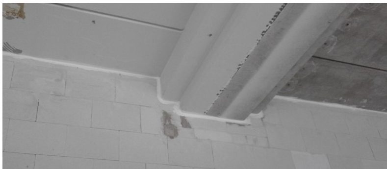
Kuva 7. Elastisia (silikoni) palokatkomassoja käytetään laajasti muun muassa saumauksissa.
