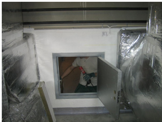
Kuva 3. Palokatkon asennus vaatii palokatkosuunnitelman ja ammattitaitoa.
