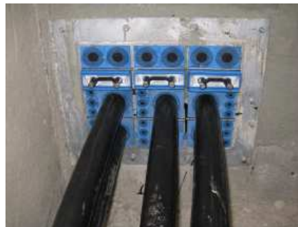
Kuva 5. Modulaarinen palokatko sopii sähköläpivienneille, joissa tarvitaan joustavuutta, paineenkestoa ja mahdollisia jälkikäteen tarvittavia varauksia.
