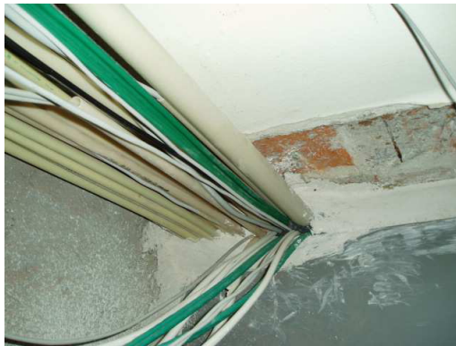
Kuva 3. Kaapeliläpiviennin tiivistäminen kipsipohjaisella palokatkotuotteella. (Sisä-Suomen paloeriste Oy 2010)
