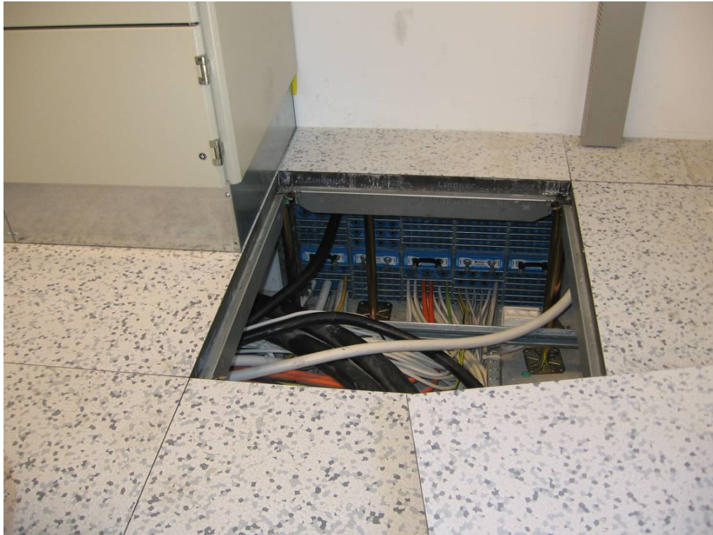
Kuva 38. Kaapeliläpivienti on tiivistetty oikein. Asennuslattian alapuolinen tila on hankala tarkastaa. (Roxtec 2010.)
