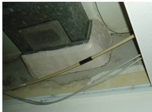
Kuva 4. Kanavaläpivientiin tehty kipsipohjaisella tuotteella patitus (Sisä-Suomen paloeriste Oy 2010)
