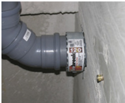
Kuvat 7. Palomansetti asennettuna viemäriputkeen (Wurth 2010)
