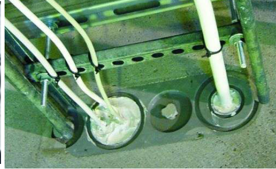
Kuva 14. Esivalmistettu läpivientikappale osana palokatkoa. (Sewatek 2010)
