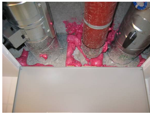
Kuva 28. Putkiläpiviennit tiivistetty palokatkovaahdolla
