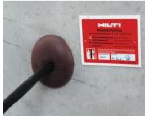
Kuva 16. Palokatkotulpalla toteutettu palokatko (Hilti Oy 2010)
