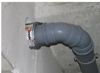
Kuva 5. Palowrappi asennettu palo-osaston läpimenevään viemäriputkeen. (Wurth Oy 2010)
