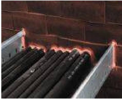
Kuvat 15. Palokatkotuilla toteutettu palokatko (Hilti Oy 2010)
