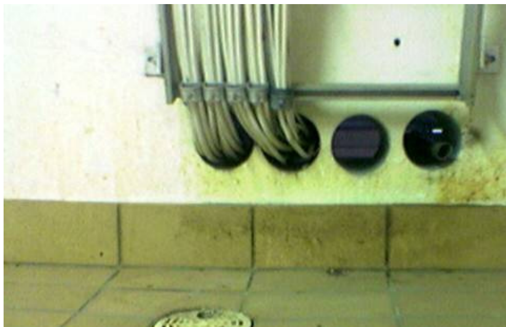
Kuva 26. Tiivistämätön sähköläpivienti osastoivassa seinässä
