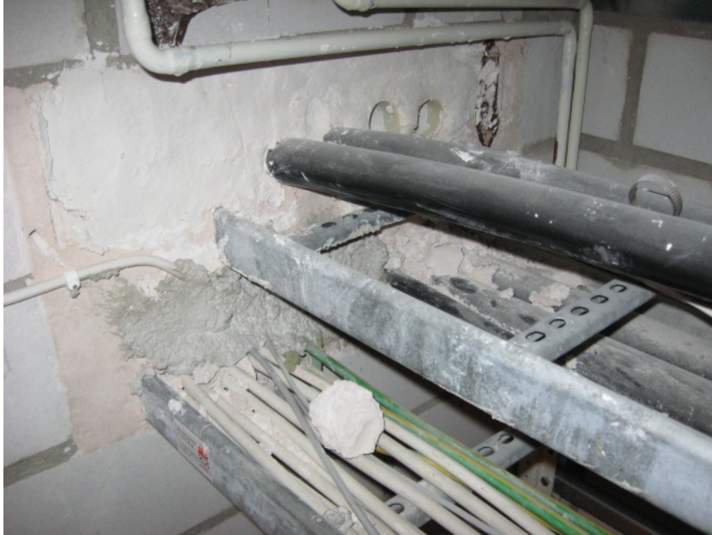
Kuva 30. Kaapelipalokatko, johon on vuosien varrella tehty muutoksia
