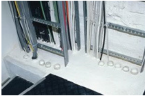
Kuva 13. Kipsipohjaiseen palokatkoon asennettu läpivientivarausta (Palokatkotukku Parkkinen Oy 2010)
